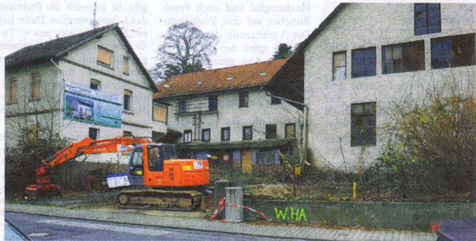
Die alte Lederfabrik an der Hauptstraße wird abgerissen. Dort sollen nach dem Bau der Doppelhaushälften an der Weingasse weitere Wohn- und Geschäftshäuser entstehen.
