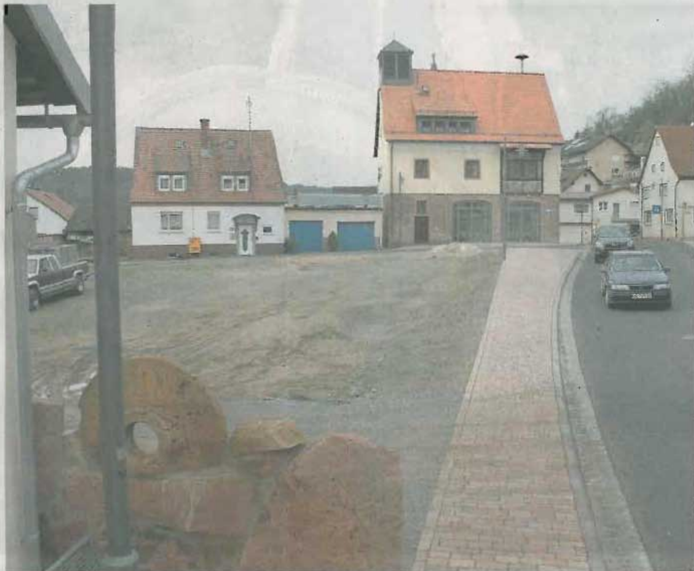
Ein Schmuckstück soll der Dorfplatz im Ortskern Rück werden. Durch den Abriss einer Doppelgarage am alten Rathaus (Bildmitte) wird ein Zugang zum Bereich hinter der St. Johanneskirche geschaffen. Foto: Martin Bachmann
