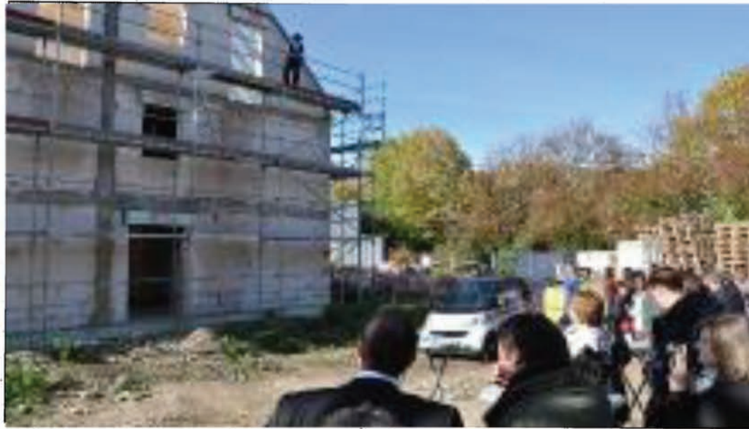
Richtfest im Kropbacher Weg: 16 Reihenhäuser stehen bereits.
