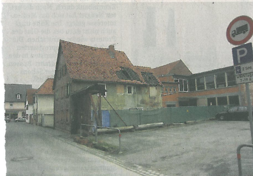
einsturzgefährdeten Gebäude in der Kanzleistraße werden abgerissen.
