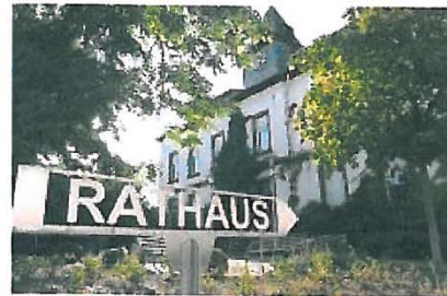
Das ehemalige Rathaus in der Schulstraße soll, unter Erhalt der Fassade, zum Boardinghouse umgebaut werden. Foto: Michael Kapp
