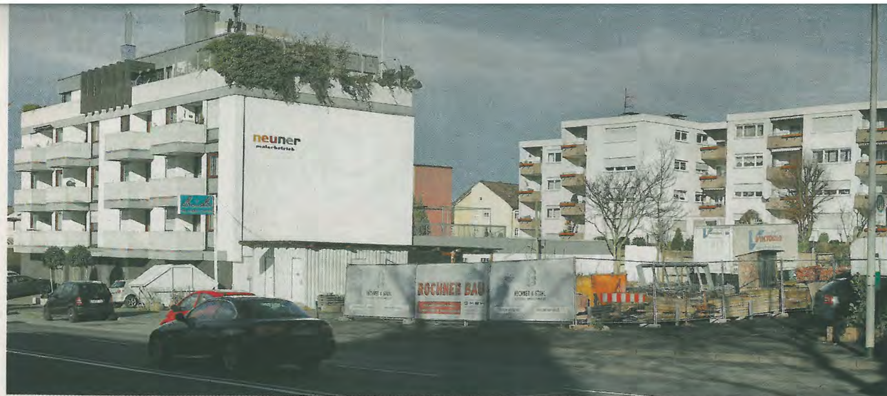
Baulücke Würzburger Straße 105: Der geplante Neubau – auch mit Studentenappartements – soll nach dem Willen der Stadt auf das Nachbargebäude Rücksicht nehmen.
