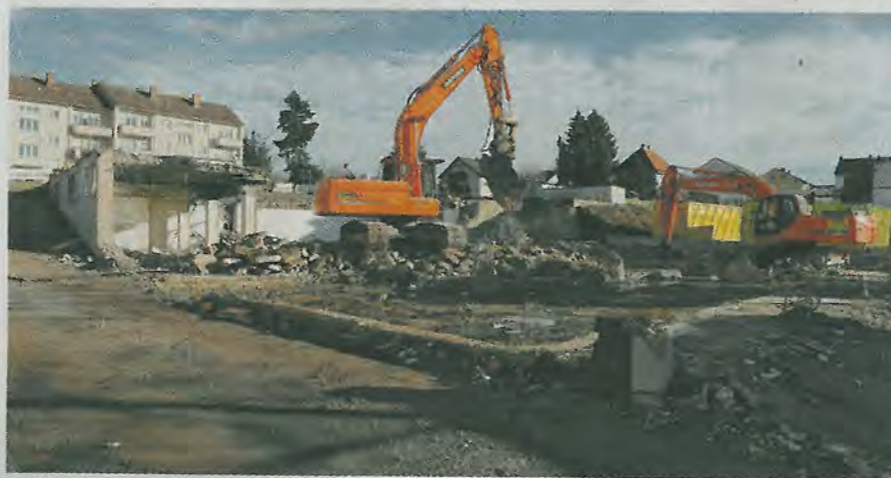
Amberg-Gelände Würzburger Straße 67: Mit dem Abriss der Altbauten nimmt das Cicero-Projekt Fahrt auf. 100 Appartements für Studenten sollen hier entstehen.
