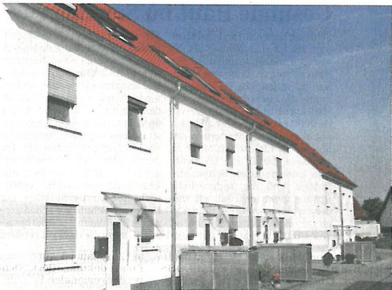
So sollen sie mal aussehen, die Reihenhäuser an der Straße „Am Goldacker“. Im September beginnen die Bauarbeiten.
