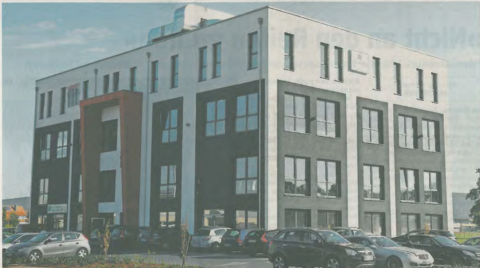
Am Stachus in Elsenfeld ist in neun Monaten Bauzeit ein neues Dienstleistungs- und Handelszentrum entstanden.
