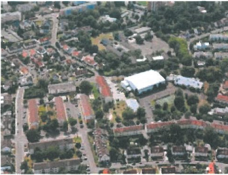
Die Cardwell-Area ist die letzte Militärfäche, die entwickelt werden soll.
