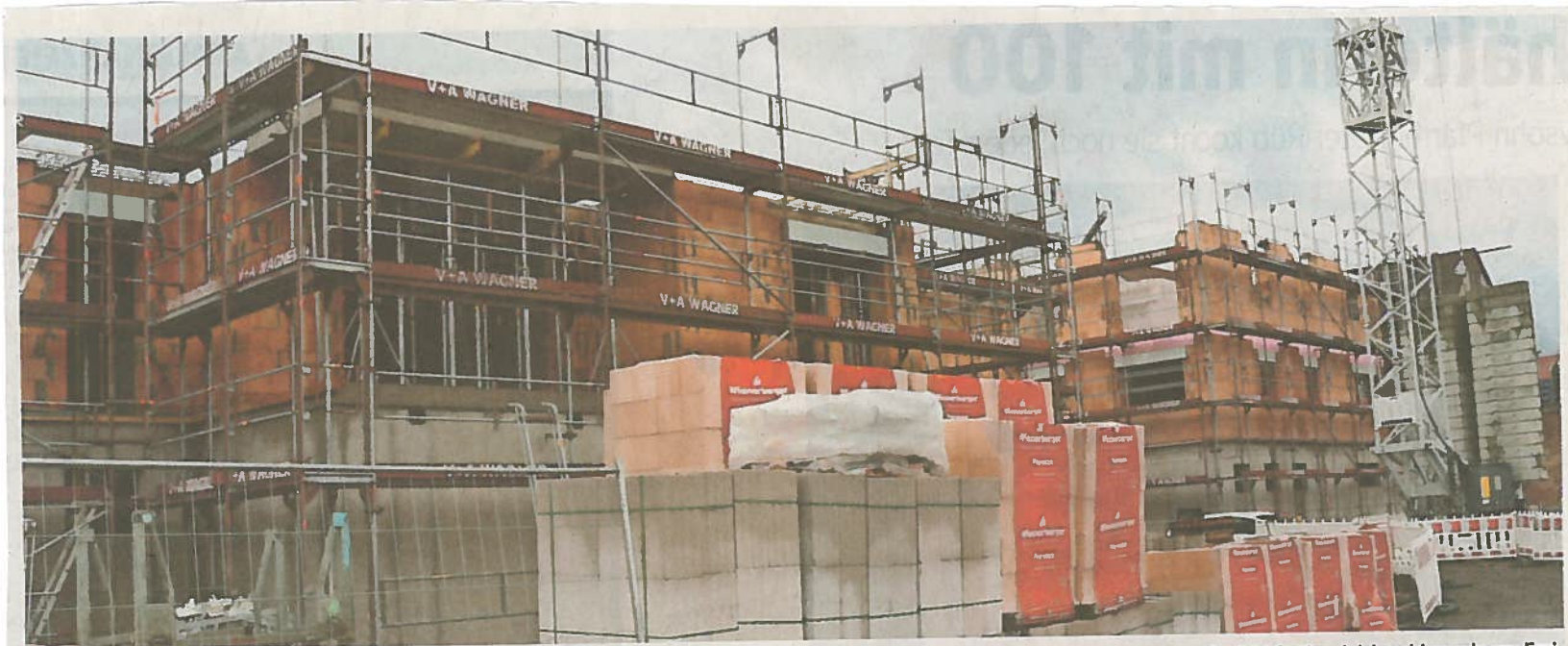
Das Bauprojekt »Mainterrassen« auf dem ehemaligen Gelände der Martinsbräu nimmt allmählich Konturen an. Der Rohbau ist zwar noch nicht fertig, gleichwohl wurde am Freitag schon Richtfest gefeiert.
