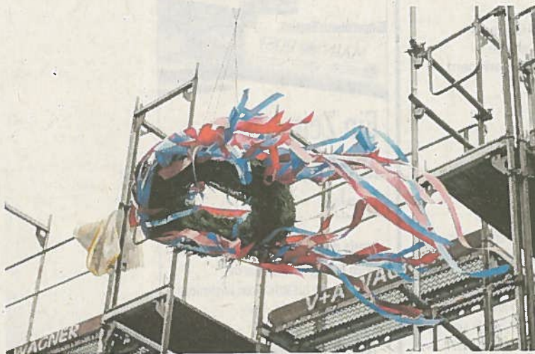
Die Firma Dreger feierte mit den zukünftigen Bewohnern das Richtfest beim Bauprojekt „Mainterrassen“ Marktheidenfeld. FOTO: DANIELA ARNDT
