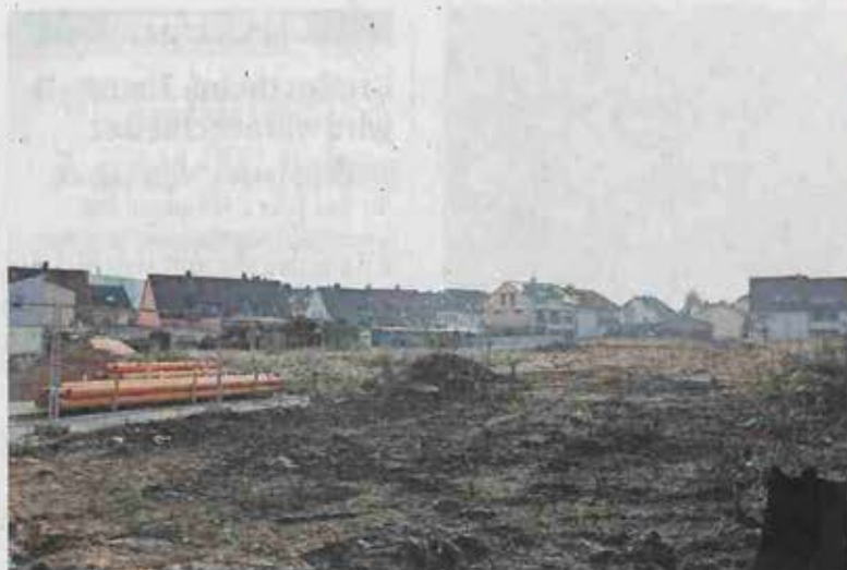
Die Kanalrohre liegen schon bereit: An der Stockstädter Straße »Auf dem Grund« sollen 27 Einfamilienhäuser entstehen.
